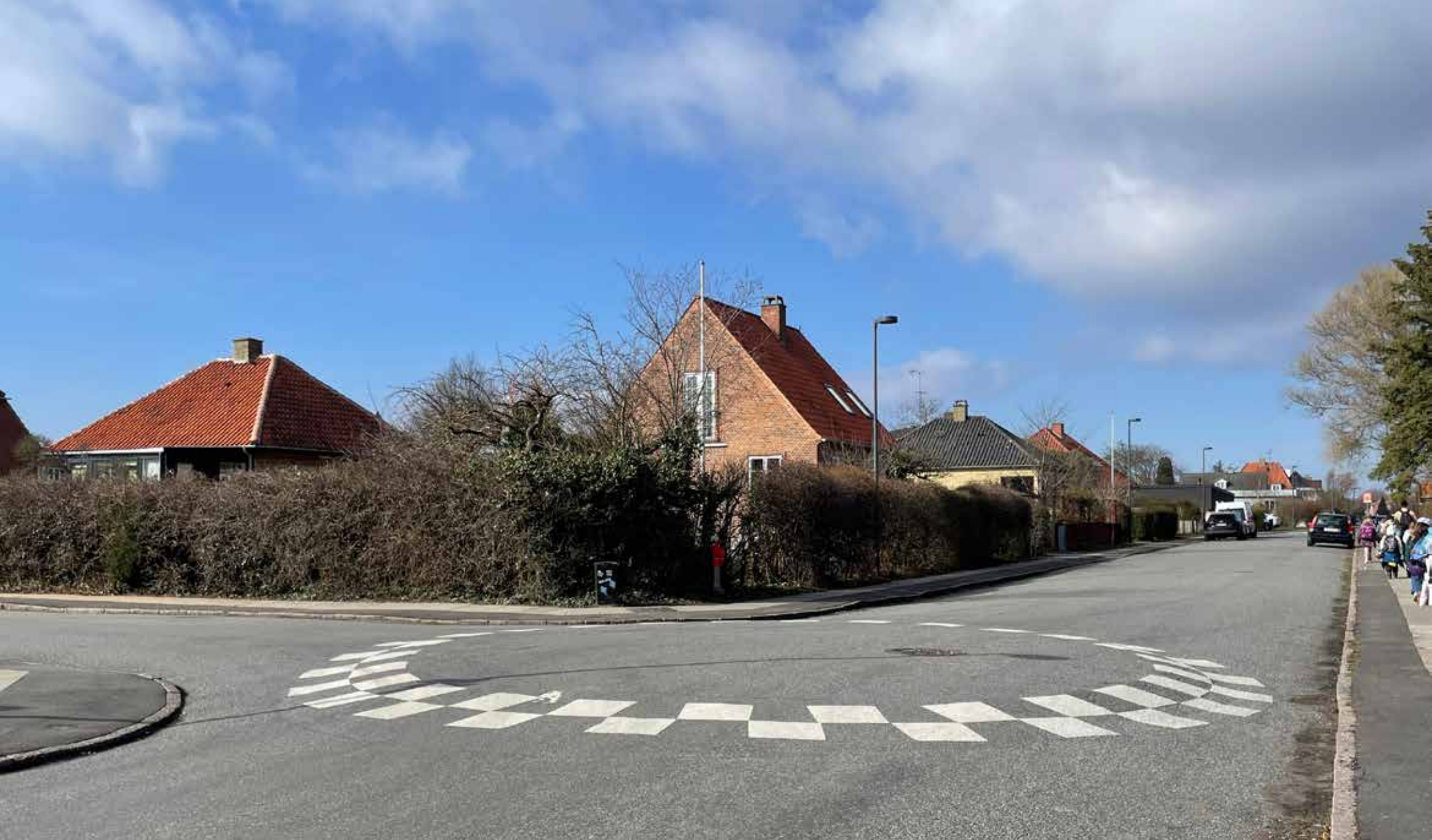
Rundt pukkelbump i veikryds, Grækenlandsvej
